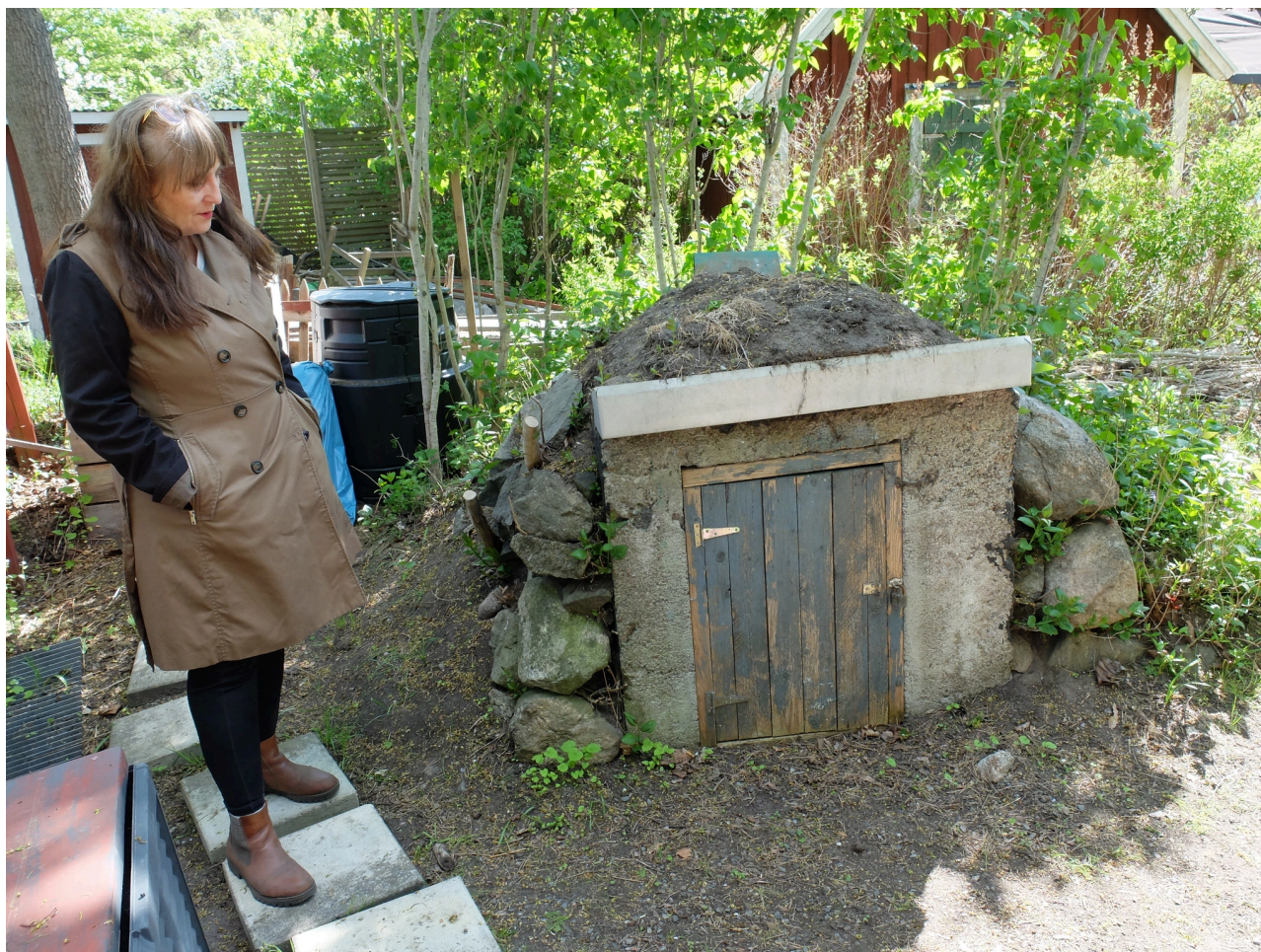
Så småningom är det dags att ta itu med den inrasade jordkällaren. Foto: Josephine Askegård
